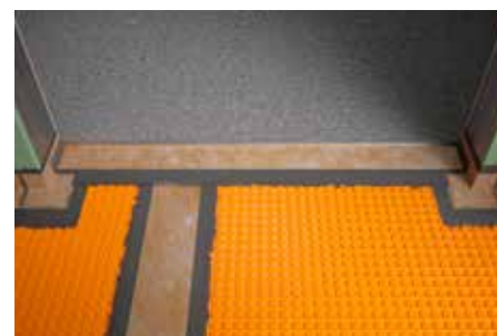
Schlüter-KERDI-CID z okładziną układaną na warstwie spadkowej (maksymalny spadek 6%)
